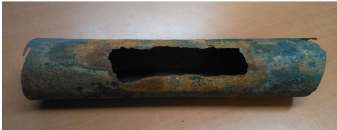
Photo de la conduite d'eau
